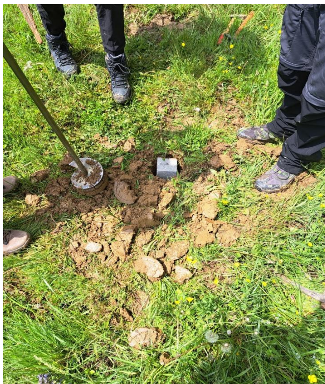
Slika 5.12 Stabilizacija točke 3.
