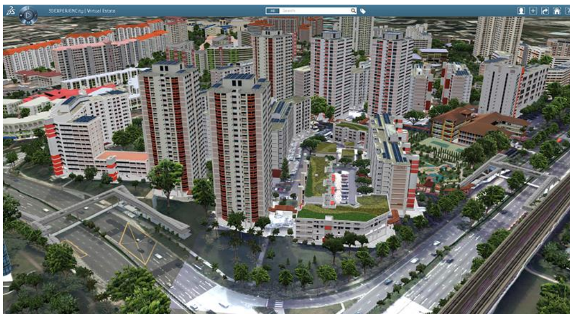
Slika 4.4. Isječak platforme digitalnog blizanca Singapura (URL 35)
