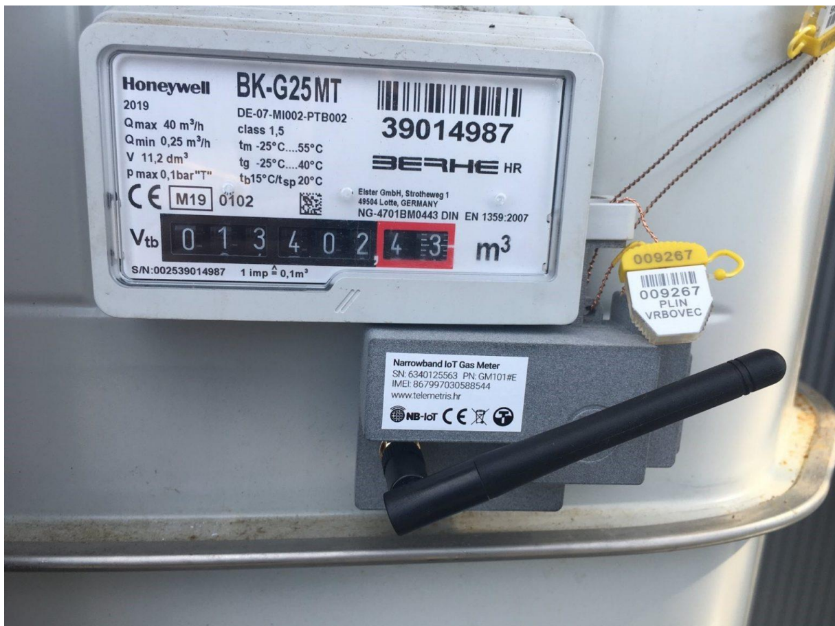
Slika 3.: Uređaj za daljinsko očitavanje brojila
